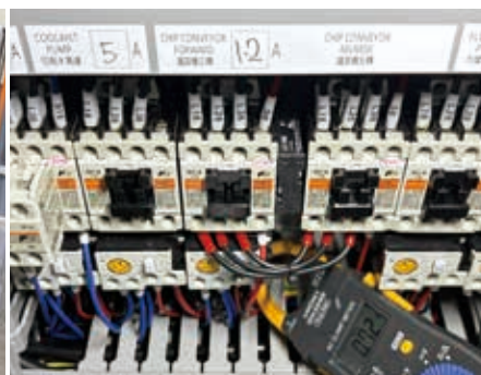
圖三 電磁接觸器量測位置
