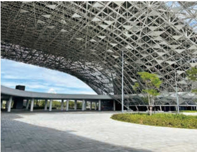
台中國際會展中心大樹之門（TREE GATE）戶外廣場
