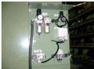
圖五 定位檢出器及電氣零件安裝
