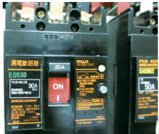
圖二 漏電斷路器
