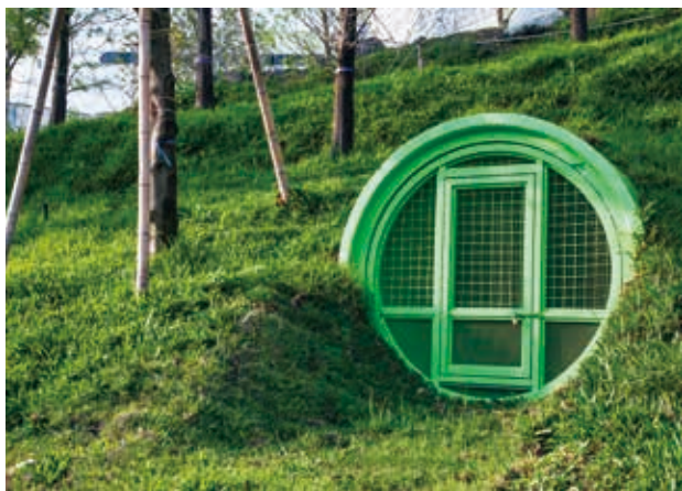
台中精機營運總部的地下涵管，在夏季裡發揮了散熱降溫的功能。
